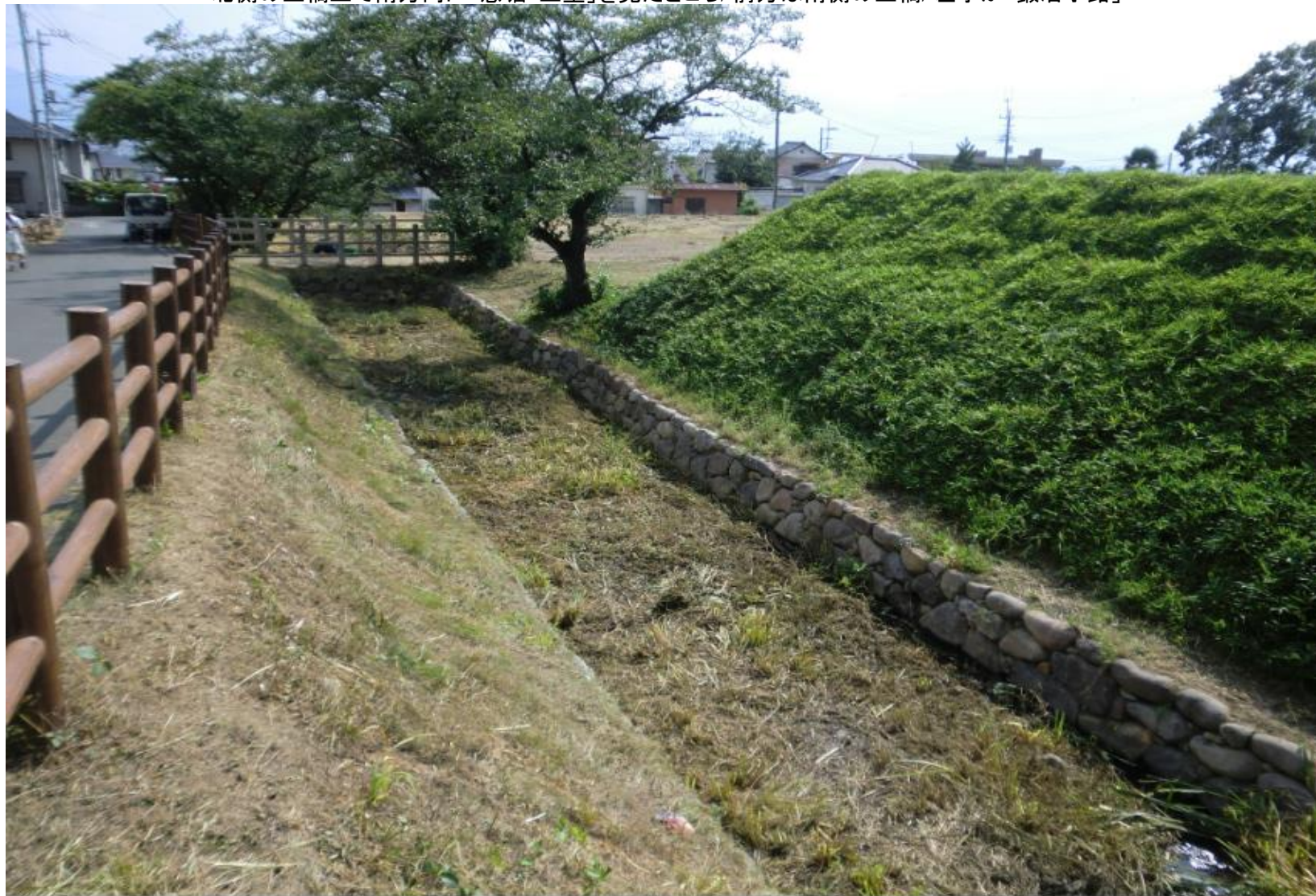
北側の土橋上で南方向に「惣堀・土塁」を見たところ/前方は南側の土橋/左手が「鍛冶小路」
