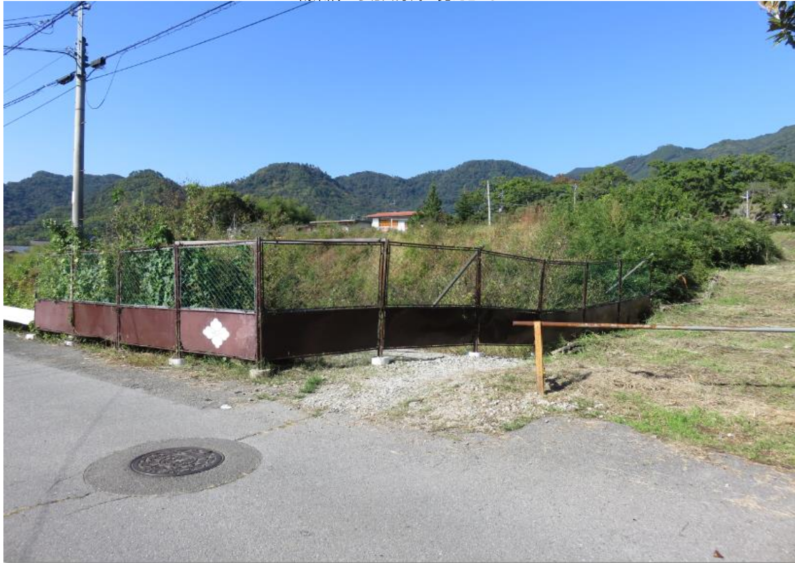
南東隅から北西方向に見たところ
