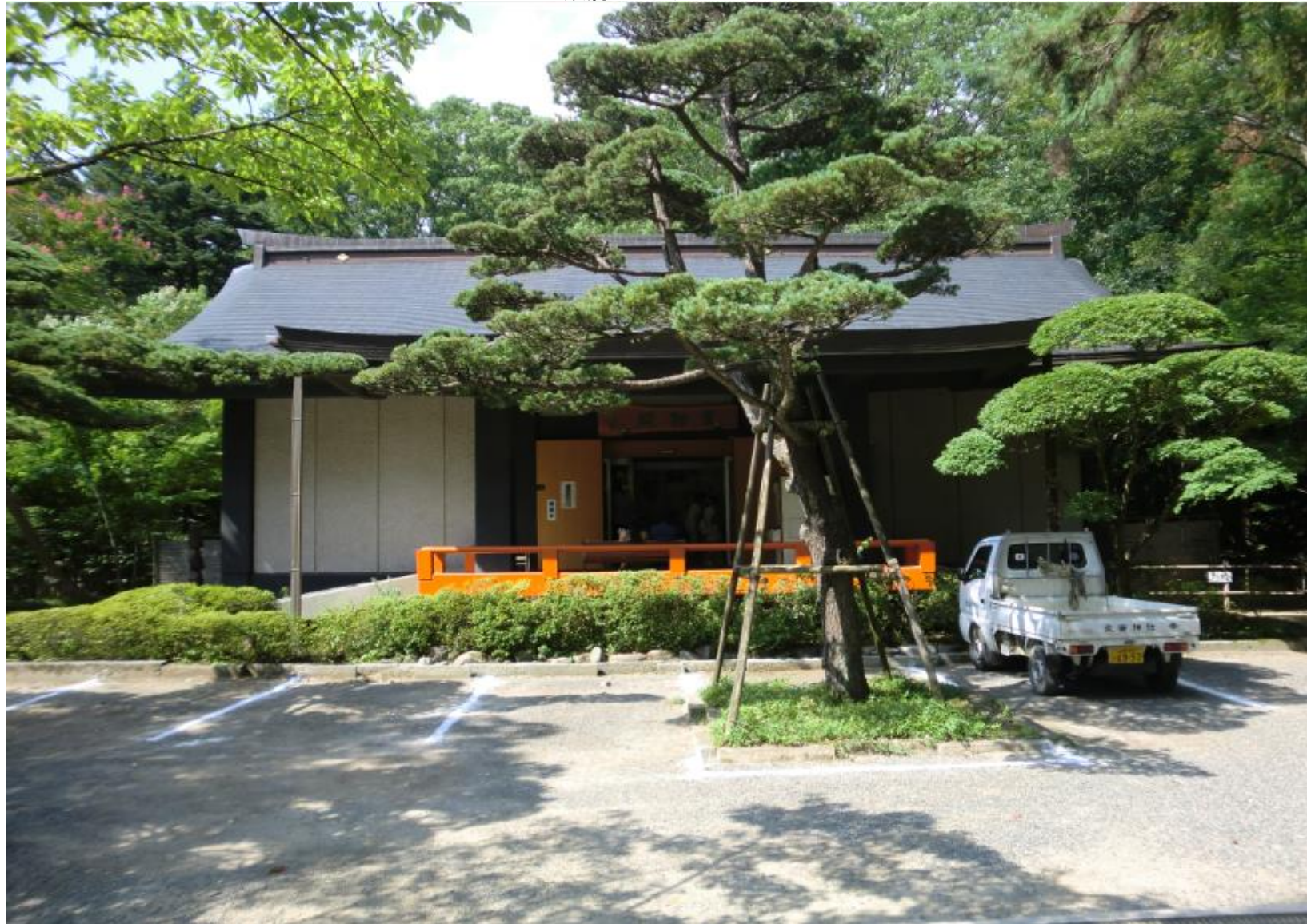
鉄筋コンクリート造
